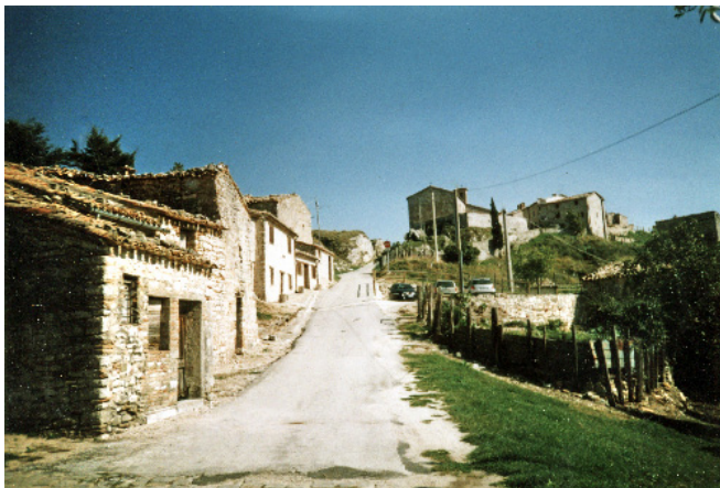
Elcito - Ingresso da occidente.
