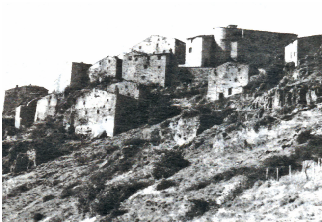
Elcito - Particolare visto da oriente.
