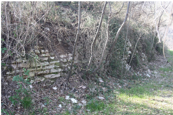
Foto n. 15: Resti di mura perimetrali della Torre.
