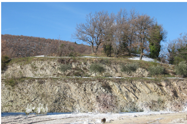
Foto n. 10: Lavori di sbancamento al colle della Torre.
