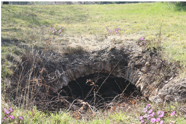
Foto n. 13: La volta in pietra del sotterraneo della Torre.
