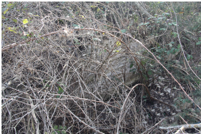
Foto n. 16: Resti di fondazioni del borgo fortificato.
