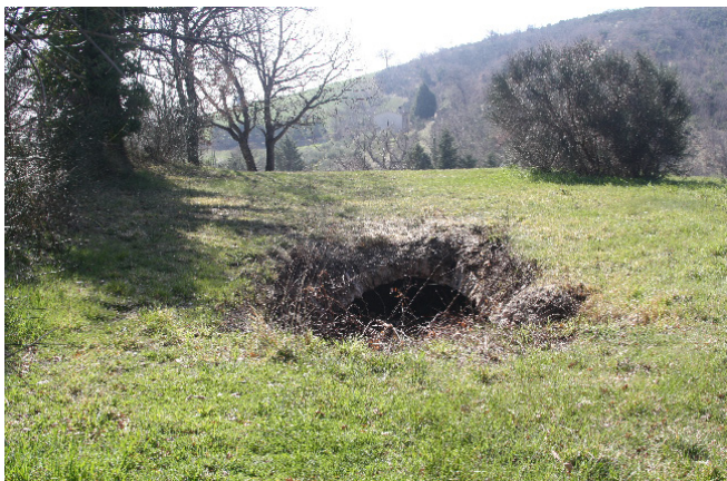
Foto n. 12: Resti del sotterraneo della Torre, sconvolto e ora quasi colmo di detriti.
