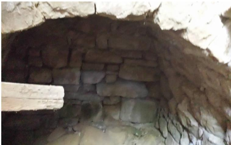
Foto 69 – Ingresso inferiore interno (alla torre?) chiuso con muro a pietra
