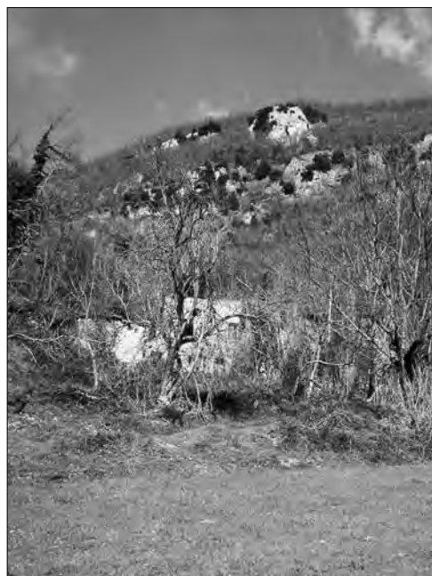
Ruderi della casa in località Acqua della Vita
