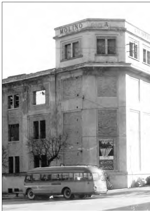
Un autobus del servizio Sanseverino - Macerata
