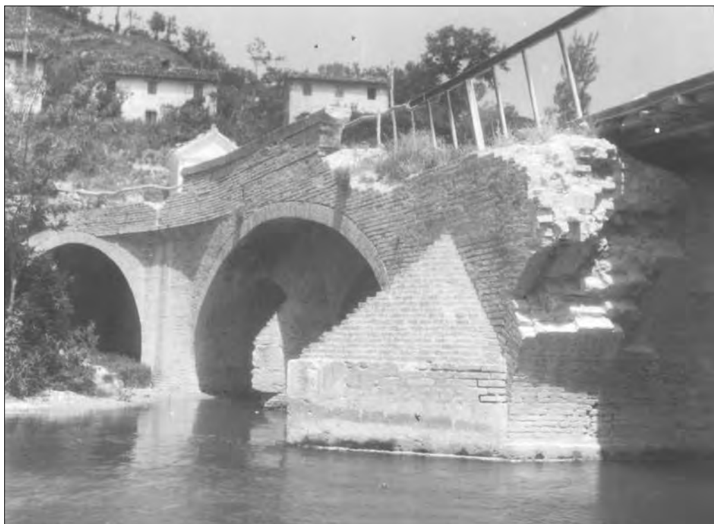
Ponte di Sant'Antonio danneggiato dai tedeschi
