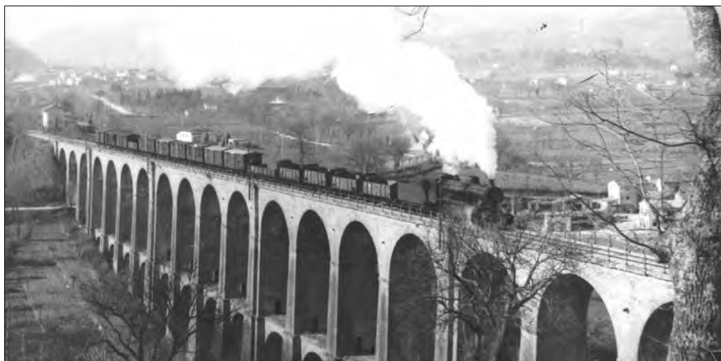
Viadotto ferroviario di San Bartolomeo
