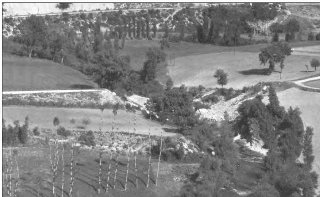
Strada Settempedana - Camerte interrotta al ponte di Crispiero
